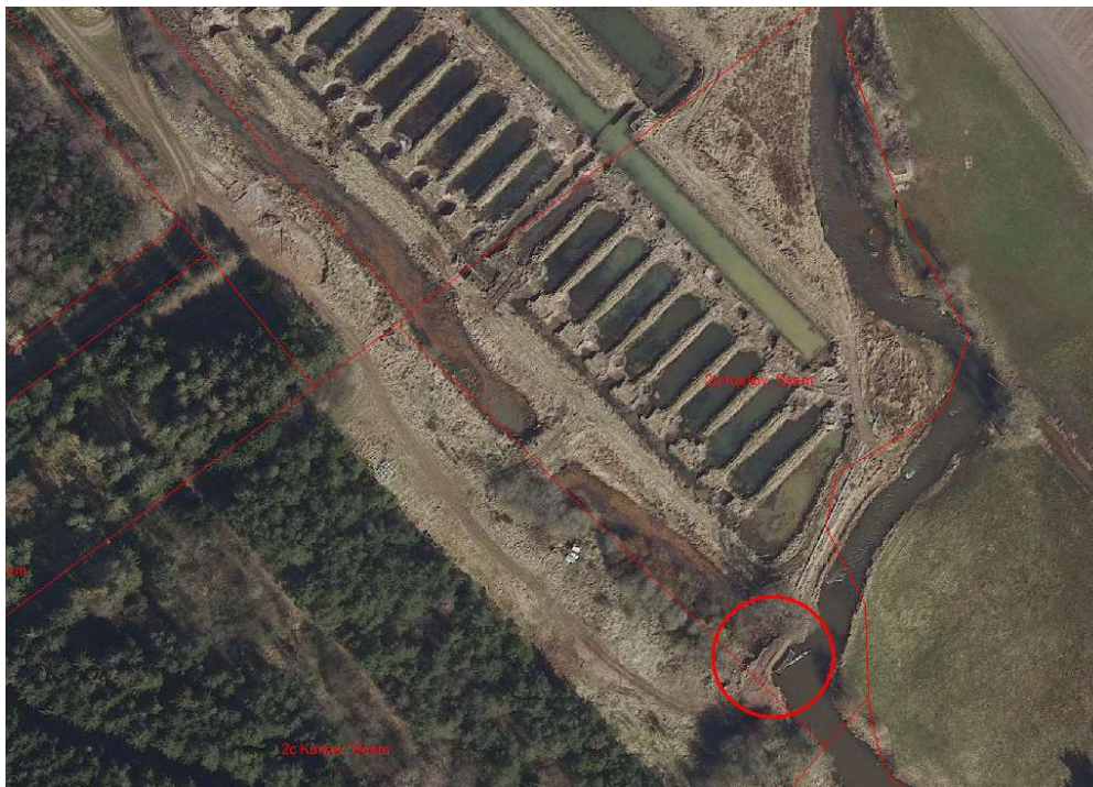
Figur 1. Det sløjfede indløbsbygværk er markeret med en rød cirkel. Se fig. 2.
