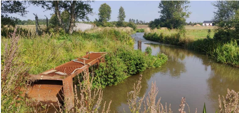
Figur 2. Det gamle indløbsbygværk 8.september 2021.
